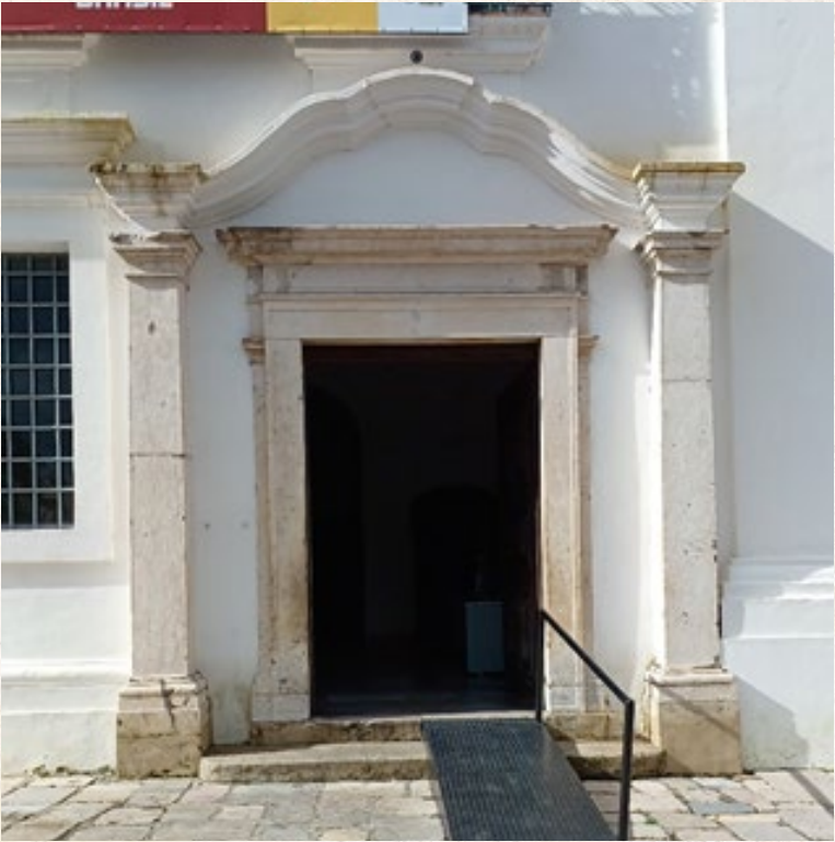
Figura 4 - Rampas de acessibilidade na área externa do Museu de Arte Sacra.
